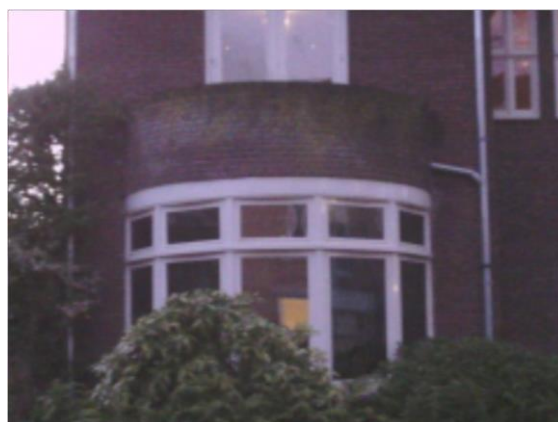
FLIR0793.jpg FLIR E53 84504498
